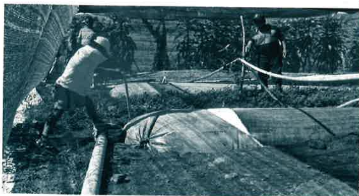
Uso de los biodigestores para la generación de biogás a partir del estiércol de cerdos en la Finca Doña Mimi.
